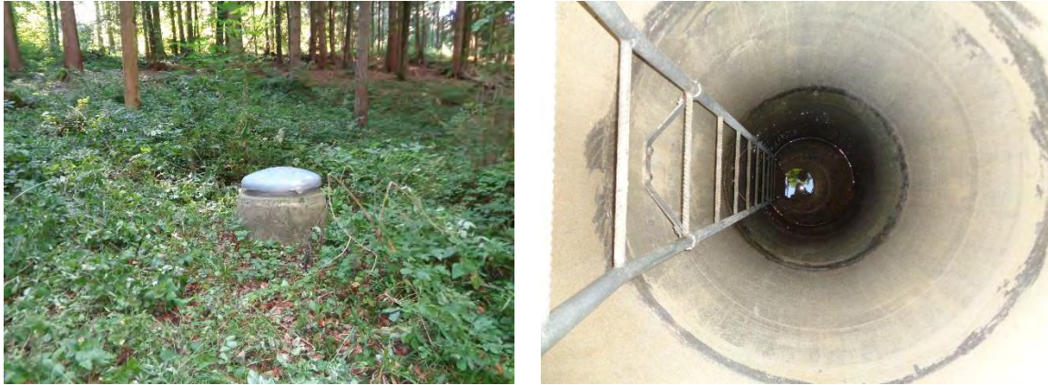
Abb. 3.30 und 3.31: Quellschacht Hugobrunnen 1b (Fotos L&H 9.9.2016)
